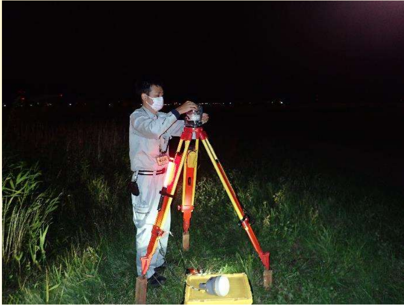
GNSS測量器の設置
